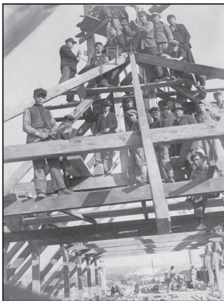
Budowa kościoła w Kątach (1929)
