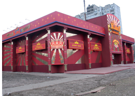
W sąsiedztwie placu budowy nowego kościoła znajduje się klub-kasyno Fot. Janusz Romaniuk
