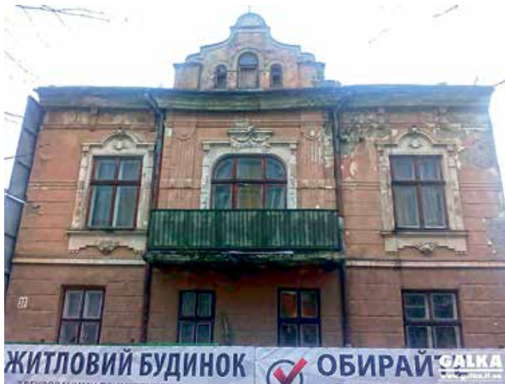
ZNISZCZONA KAMIENICA NA BELWEDERSKIEJ 37
