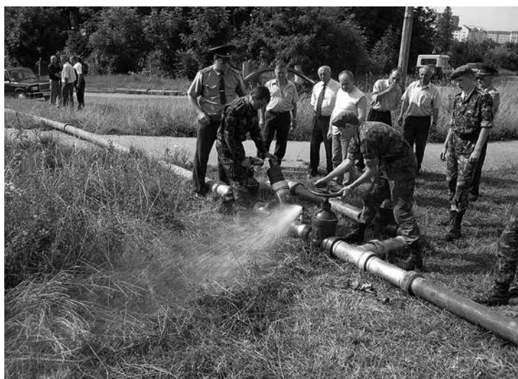
BUDOWA RUROCIĄGU W 2001 R.
