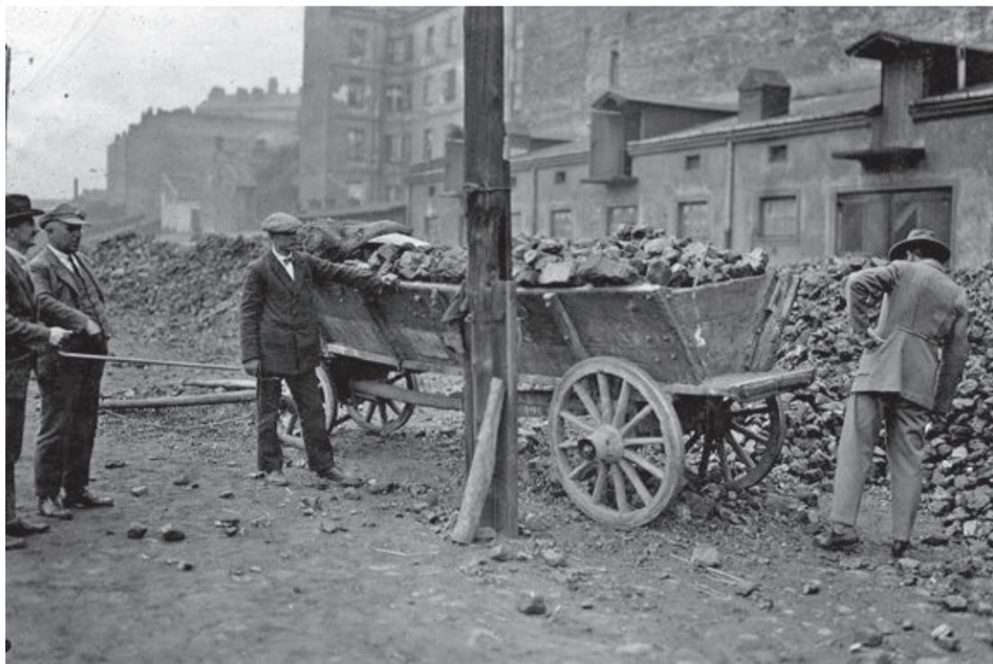
SKŁAD WĘGLA PRZY UL. ŻELAZNEJ W WARSZAWIE
