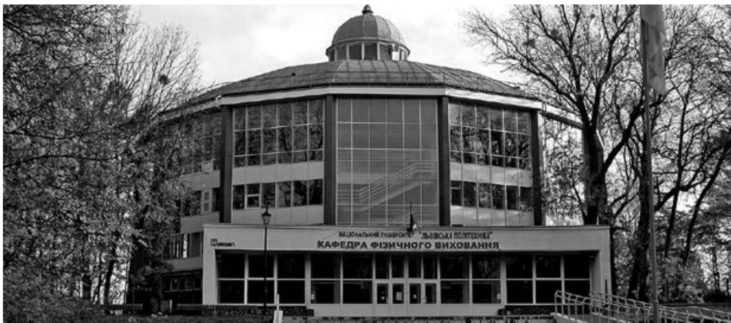
ROTUNDA PANORAMY RACŁAWICKIEJ, STAN OBECNY
