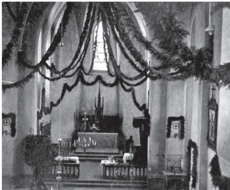
Wnętrze kościoła z widokiem na prezbiterium
