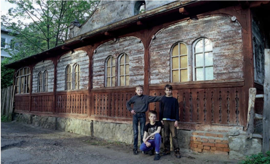
Budynek Łazienek, stan z kwietnia 2016 r.
