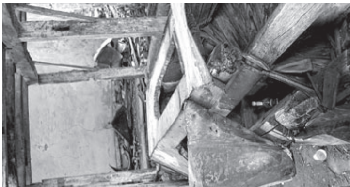
Zniszczone wnętrze kościoła w Zagórze Kąkolnickim
