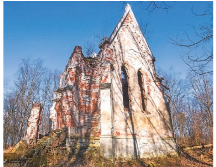
Obecny stan kaplicy Skarbków
