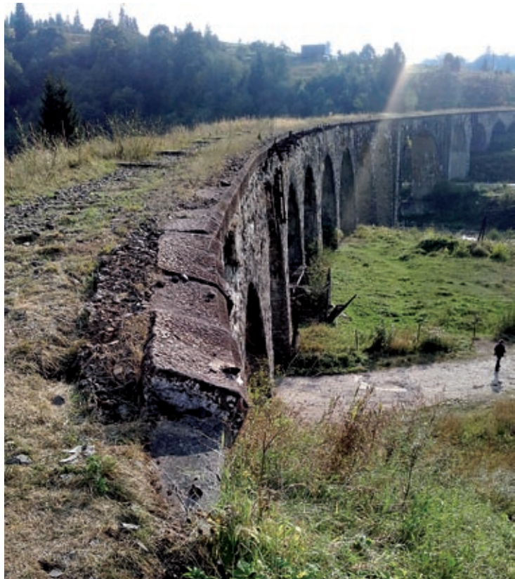
Wiadukt w Worochcie
