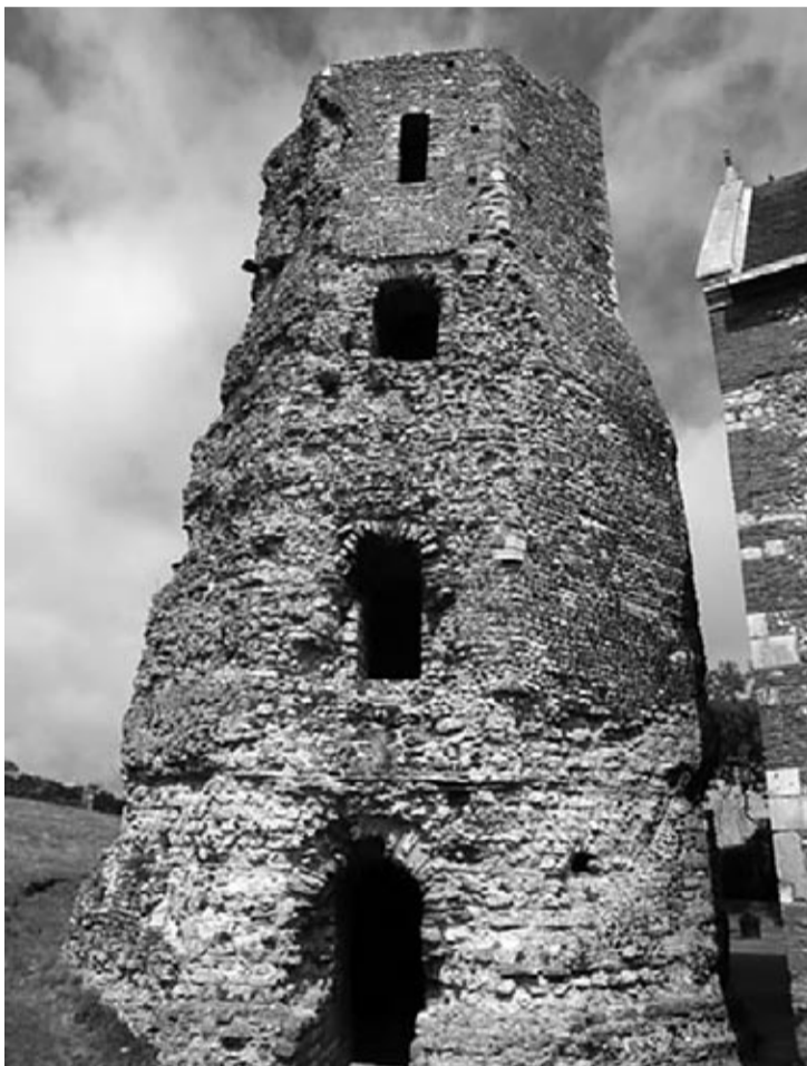
Rzymska latarnia morska w Dover, Wielka Brytania
