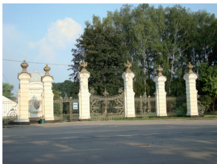
Brama wjazdowa – pozostałość po pałacu Potockich w Antoninach
