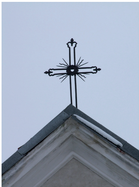
Krzyż na zwieńczeniu fasady kościoła pw. Świętych Cyryla i Metodego w Lubieszowie
